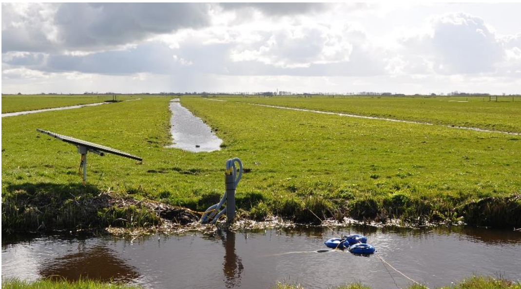
Figuur 16: Greppel plas-dras middels een zonnepomp (rondje = uitmonding pvc-buis) (Geerts, 2021).
