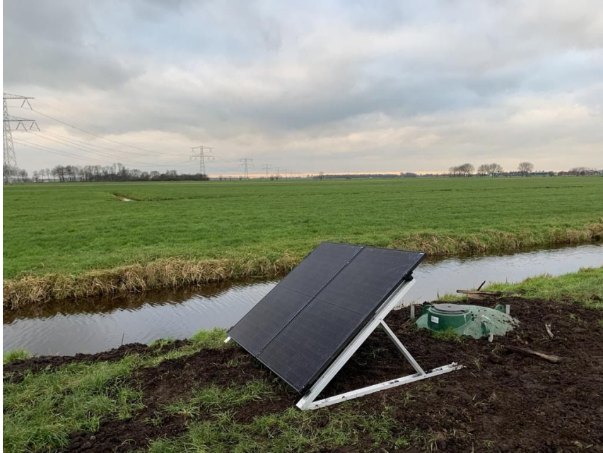
Figuur 4 Zonnepanelen voor de aanvoerpomp bij de drukdrainage
