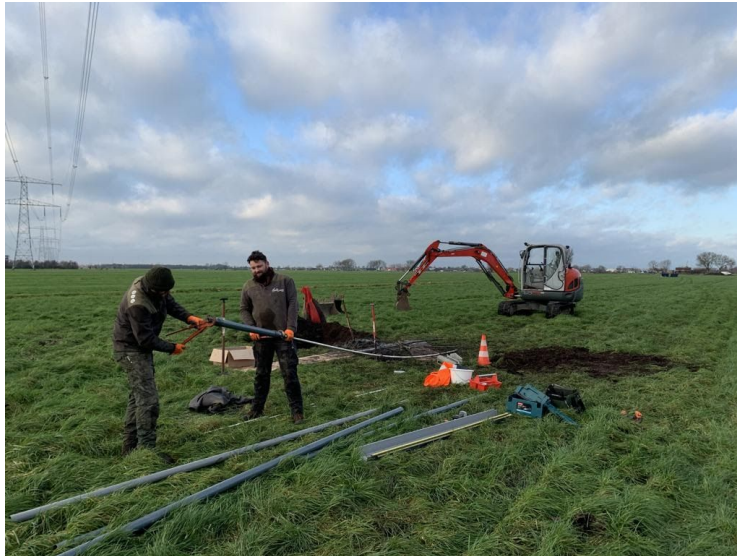
Figuur 2 Montage buis fundering staaf
