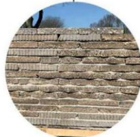
BUITENBLAD GEVEL: GEBROKEN TROTTOIRTEGELS.
